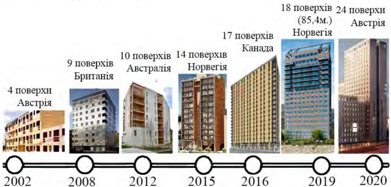
Рис. 1.8 Розвиток висотного будівництва із застосуванням поперечно-клеєної деревини
