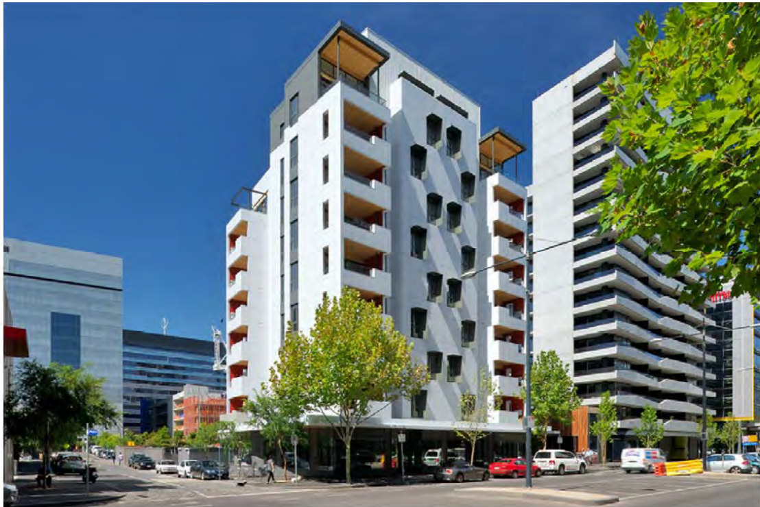
Рис. 1.11 10-поверховий будинок Forte Building в Мельбурні
